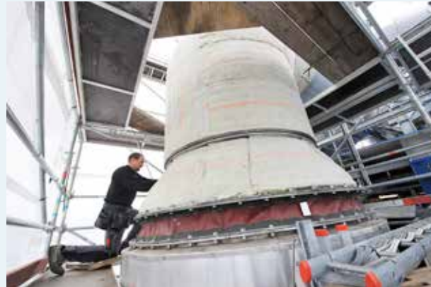
Peter Foogel mitt i isoleringsarbetet.
