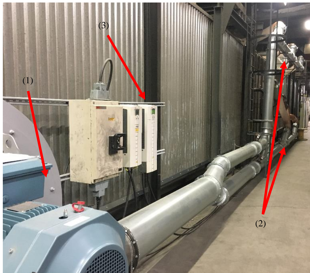
Figur 27 Bild över prototypanläggningens kylsystem: (1) Fläkt för matning av kylluft, (2) Kanaler till svaltunnels fram och baksida, (3) frekvensreglering av kylfläkten och utsugsfläkten på taket.
