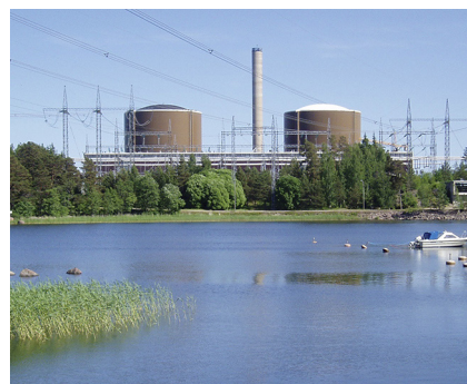
Kärnkraftverket Loviisa i Finland. Foto: Per Högselius, bilden är beskuren.
