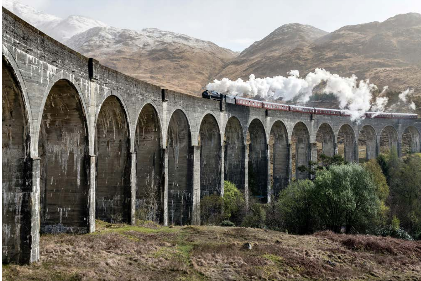
Två tekniska innovationer, valvbågen och ångloket. Här Glenfinnanviadukten i Skottland.
