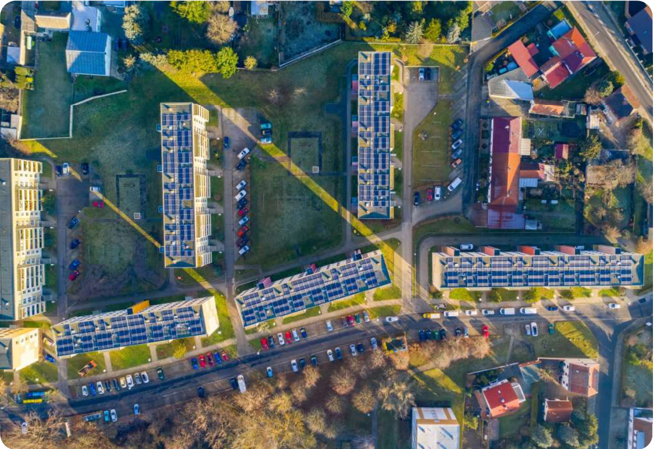
Ett lokalt energisystem utrustat med både elproducerande kraft, batterier och en smart lokal elanvändning kan avlasta elnätet och maximera egenförbrukningen i den lokala energigemenskapen.
